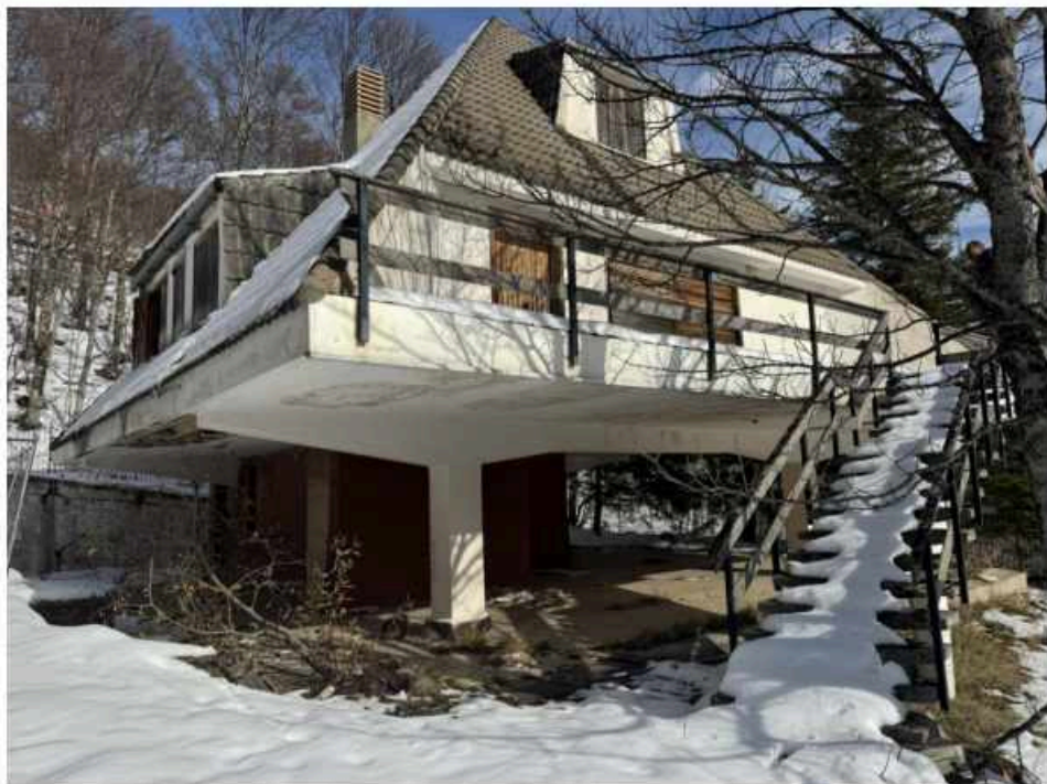
– vista del villino
