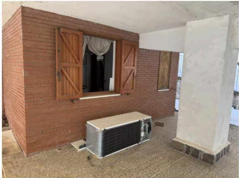
- villino (piano terra) – finestre posteriori
